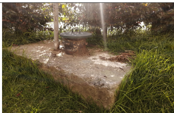
Estructura de la cabeza del pozo.
